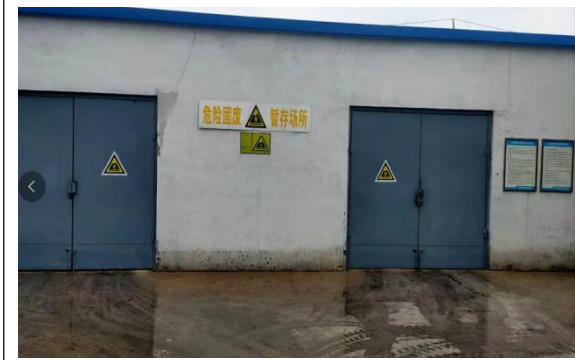
危废暂存场所
