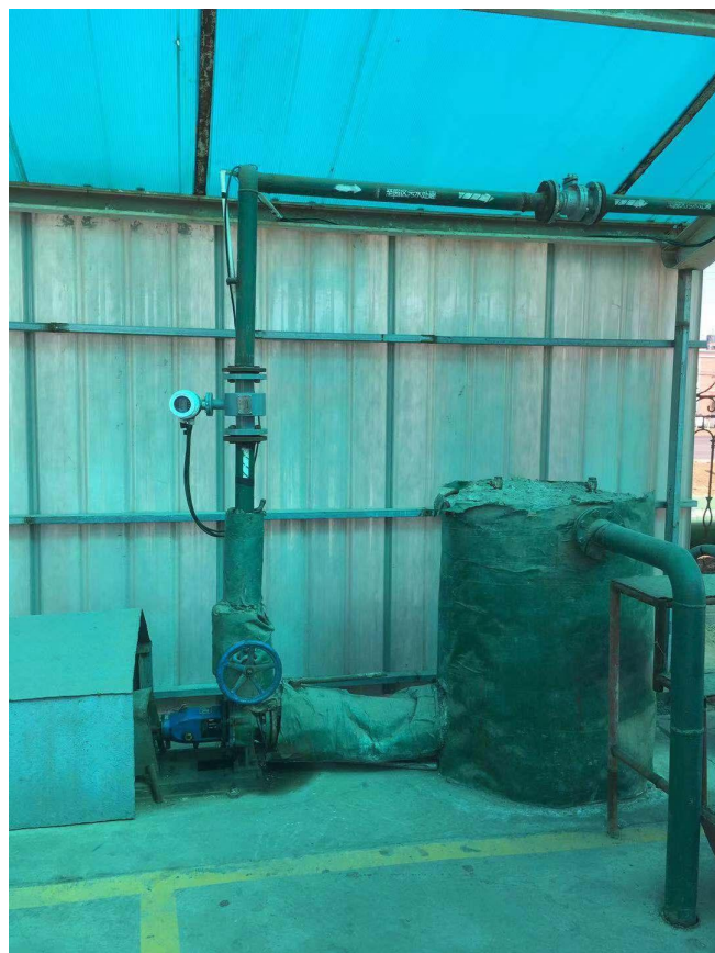
图 5.3-2 企业总排口照片
